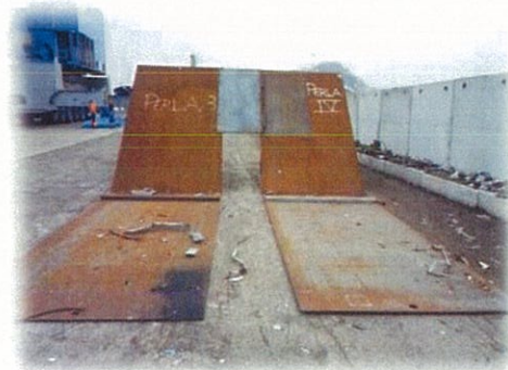
Elementos para evitar las potenciales caídas al mar de materiales, tanto para graneles sólidos con lonas (izquierda), como para chatarra u otros metales con planchas metálicas (derecha)
